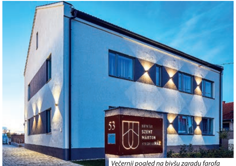
Večernji pogled na bivšu zgradu farofa
