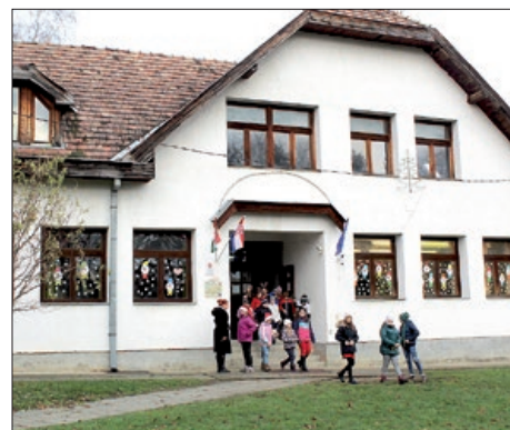
Židanska obnova školske zgrade
