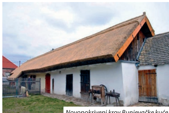
Novopokriveni krov Bunjevačke kuće
