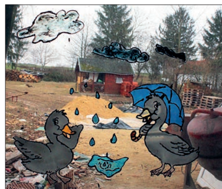
Obnova nardarske čuvarnice
