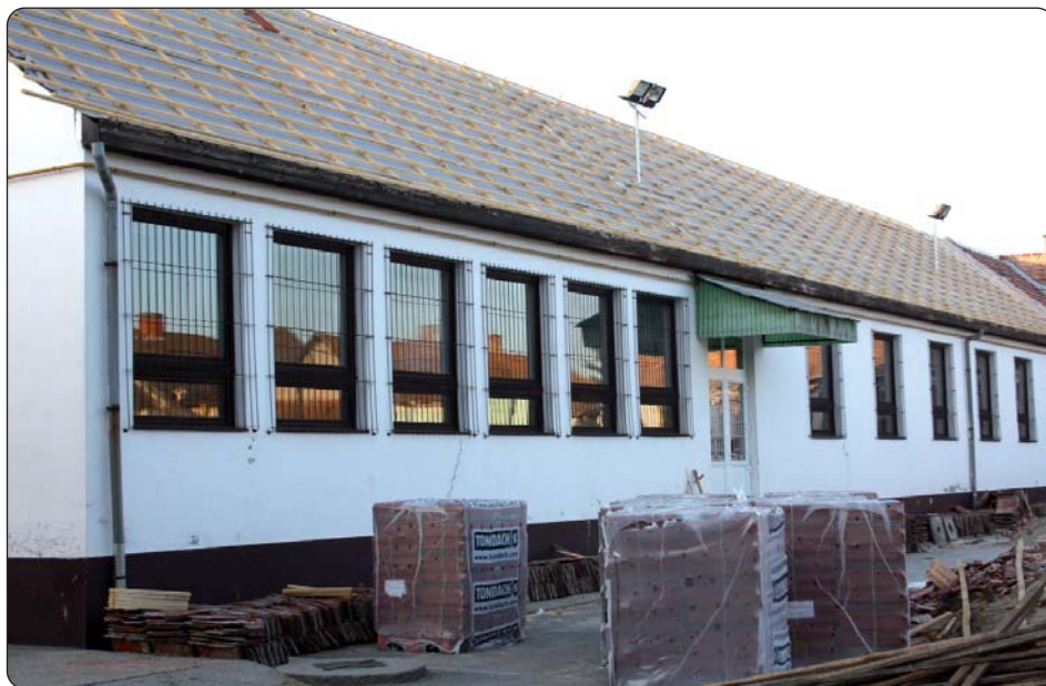
U tijeku je obnova zgrade santovačke Hrvatske škole
