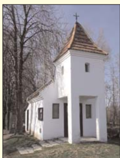
Na mjestu negdašnje mrtvačnice se gradi nova
