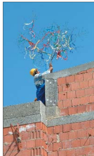
Stavljanje grane na krov budućeg učeničkog doma
